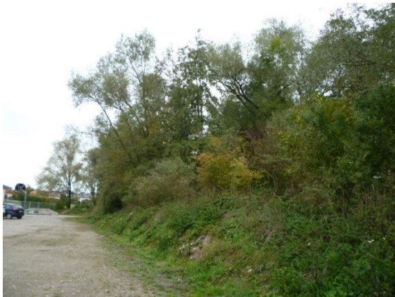
Abb. 4 Deich entlang der Ebrach, Blickrichtung. Nord-Nordwest.
